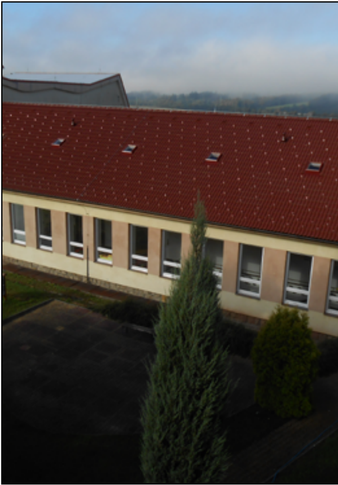
Nová střecha škola
