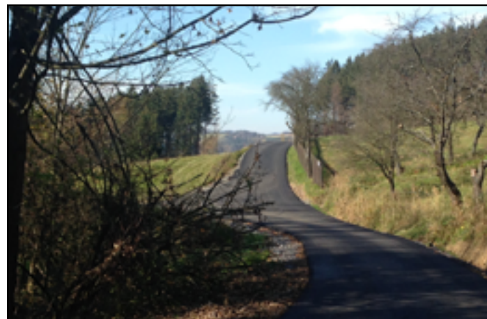
Niva po rekonstrukci
