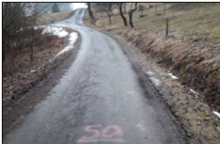
Niva před rekonstrukcí
