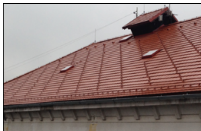
Střecha sokolovna po rekonstrukci
