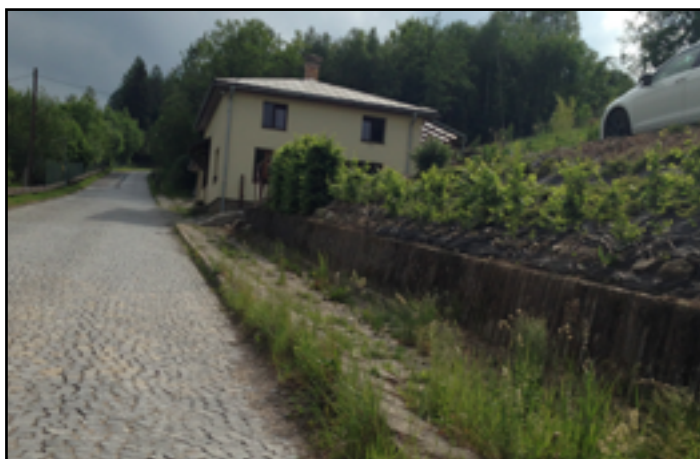
Kounikace ke Zbrojovce před rekonstrukcí
