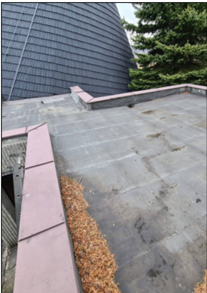
Střecha smuteční síň před rekonstrukcí
