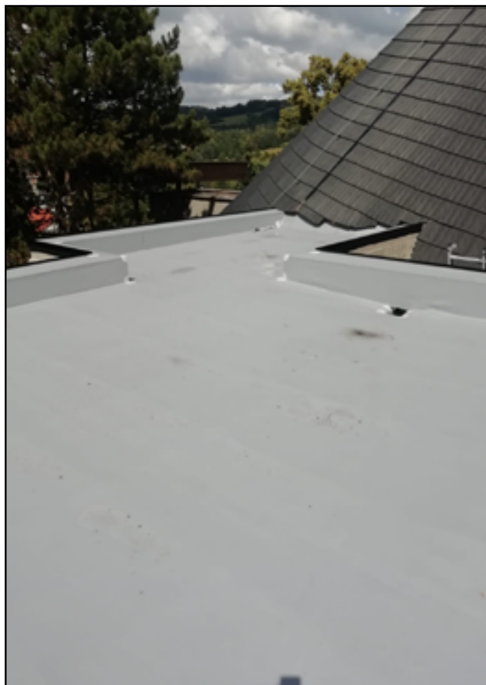
Střecha smuteční síň před po rekonstrukci
