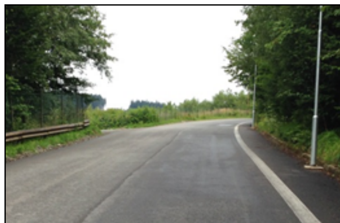
Kounikace ke Zbrojovce po rekonstrukci
