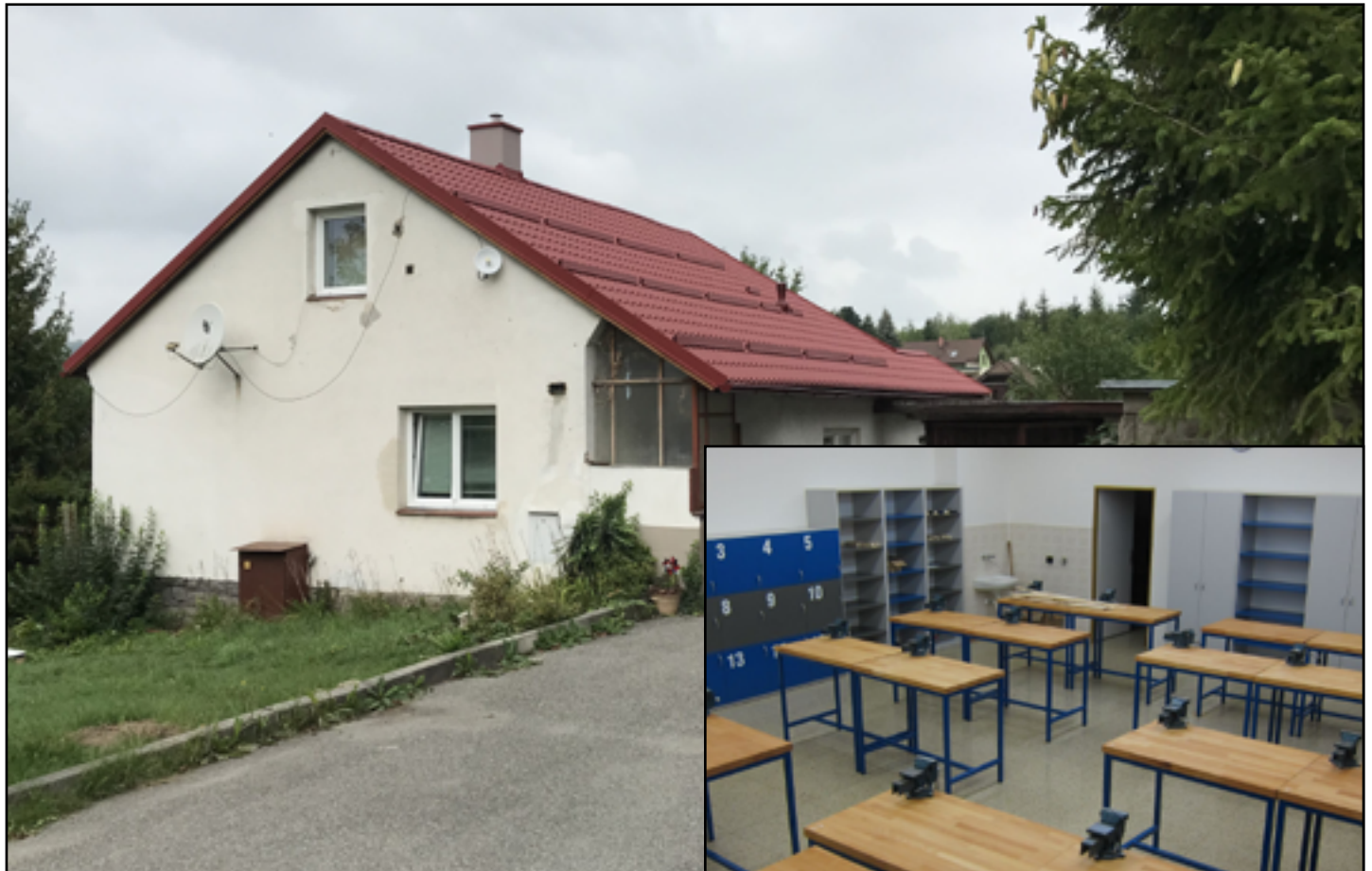
Nová střecha č.p. 307
