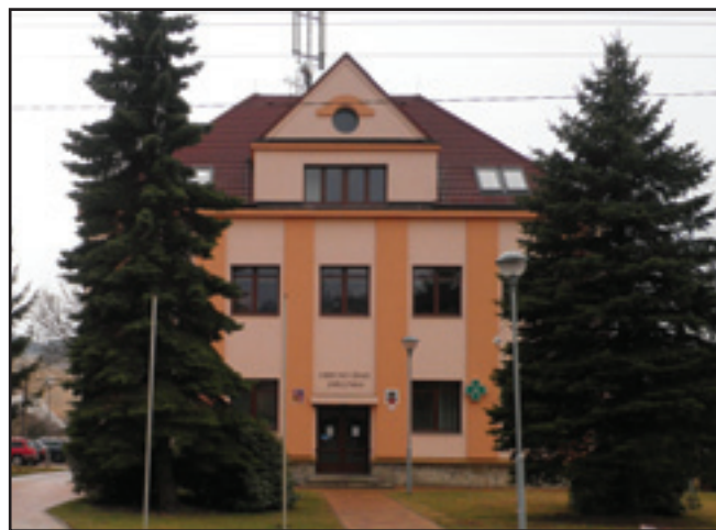
Obecní úřad nová fasáda.
