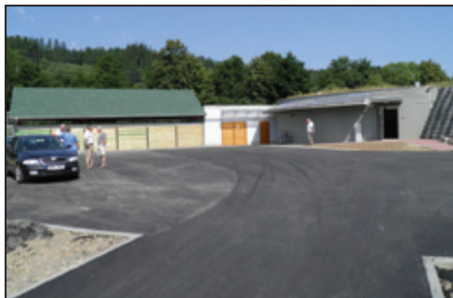
ČOV po dokončení.
